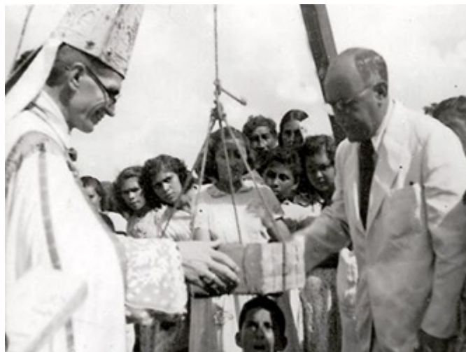
Figura 1 - Lançamento da pedra fundamental de construção do prédio do IST, tendo ao lado direito de Dom Eliseu o então prefeito Augusto Corrêa (1940).
